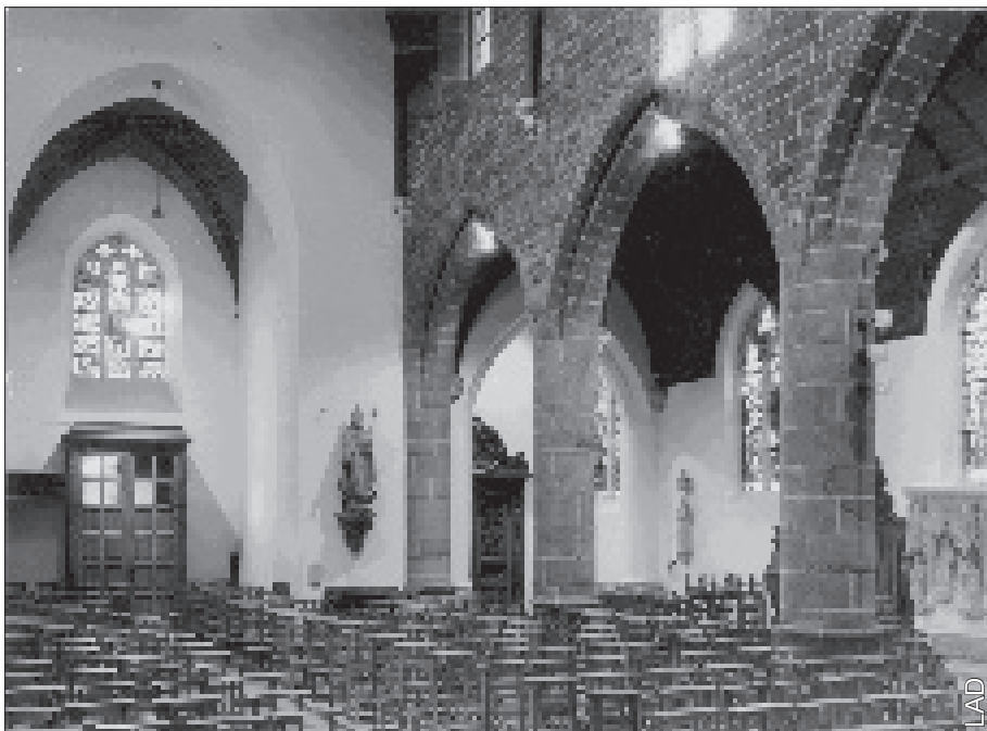
De kerk van Tessenderlo werd gebouwd in Rotselaarse zandsteen. De gekapte en glad geschaafde ijzerzandsteen werd van Rotselaar met paard en kar naar Tessenderlo gevoerd.
